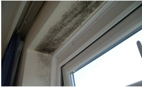
Moho oculto por la cortina debido a la condensación de humedad en el marco de una ventana
